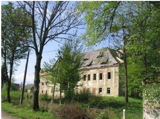
Foto vom Verfasser Abb. 85: Grunau
