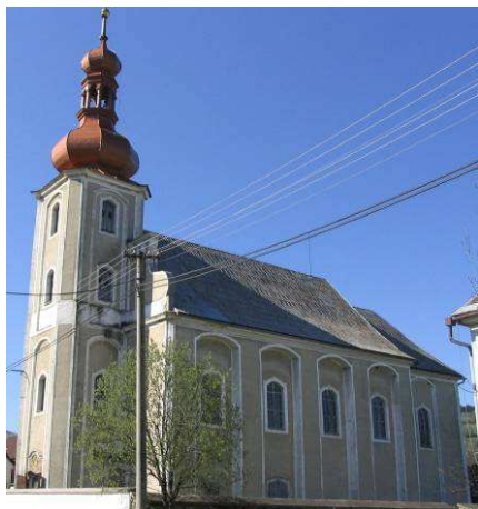
Foto vom Verfasser Abb. 74: Kirche in Thomasdorf
