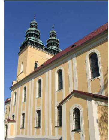
Foto vom Verfasser Abb. 25: Südseite der Kirche
