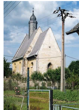
Urheber MOs810 Abb. 42 a: Eine weitere Ansicht der Friedhofskapelle
