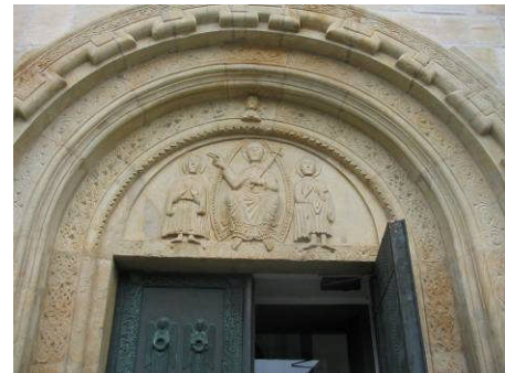
Foto vom Verfasser Abb. 109: Portal
