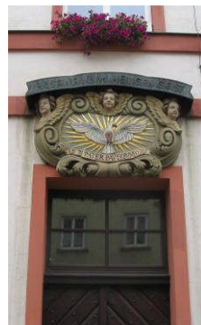
Foto vom Verfasser Abb. 120: Portal
