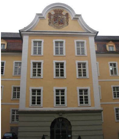
Foto vom Verfasser Abb. 49: Treppenaufgang
